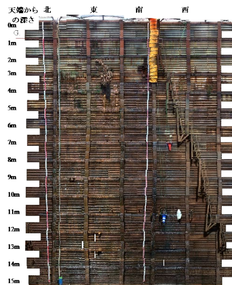
図-5 集水井内部展開写真(丸山3号)
